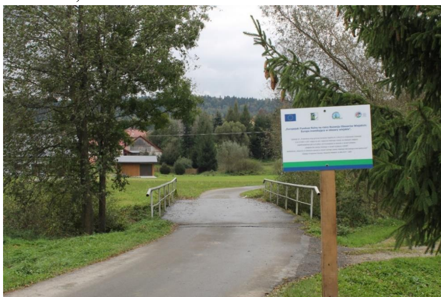
Droga Domaradz Cegielnia
