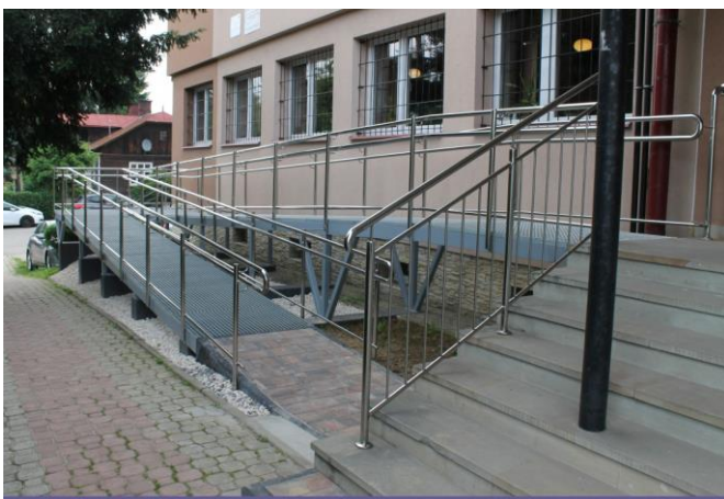
Podjazd dla osób ze szczególnymi potrzebami
