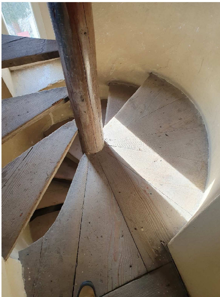
Rys. 13. Widok od góry schodów krętych na chór muzyczny
