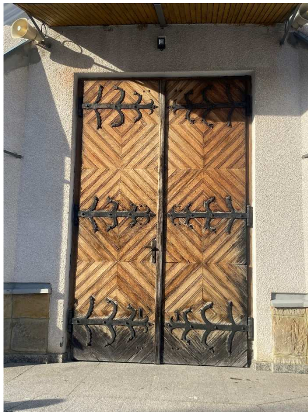
Rys. 2. Drzwi zewnętrzne od strony wschodniej
