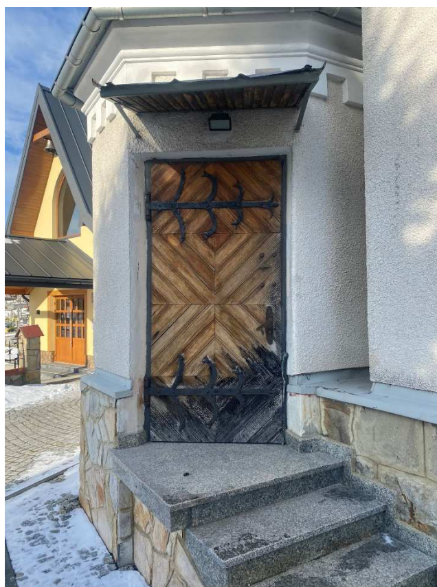
Rys. 4. Drzwi zewnętrzne od strony południowej
