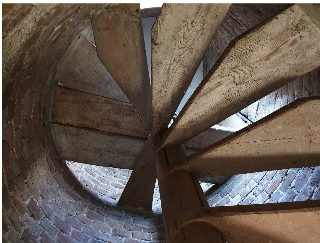
Rys. 12. Widok od dołu schodów krętych na chór muzyczny
