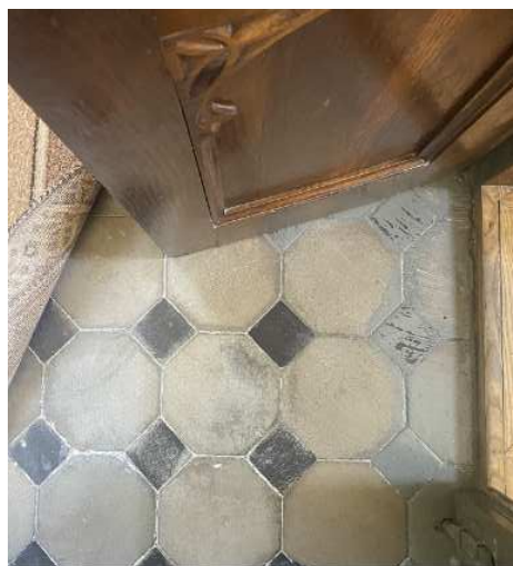
POSADZKA W ZAKRYSTII POŁUDNIOWEJ
