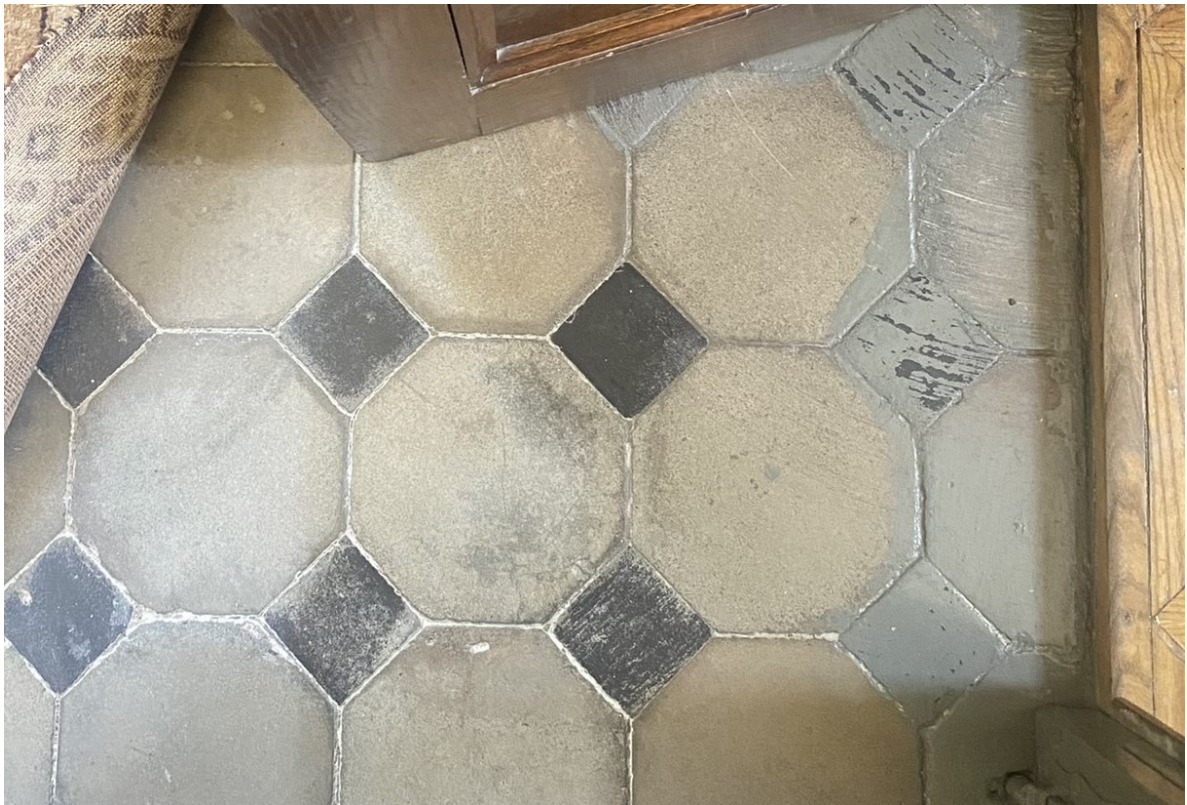
Fot. 1 – Istn. posadzka w pomieszczeniu zakrystii południowej
